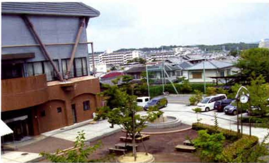
中庭に面した建物が総合館です。
